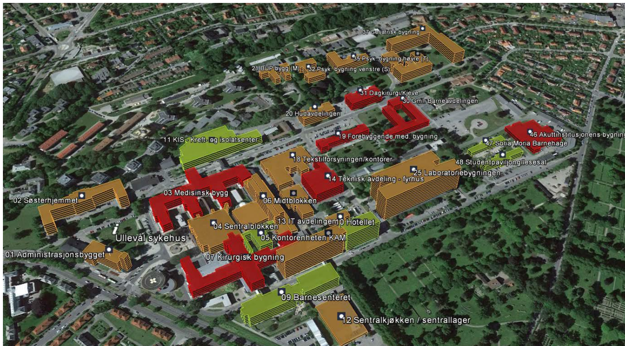
Oversikt over teknisk tilstand ved OUS, lokasjon Ullevål i 2017. Byggene er fargelagt i henhold til tilstandsgrad. Kilde: Områdeplan BYGG ved OUS HF 2020–2023.
